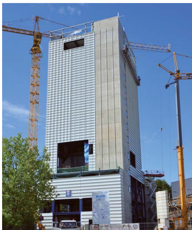
Im Bau: neue Gasturbine der VWS im Industriegebiet Süd
