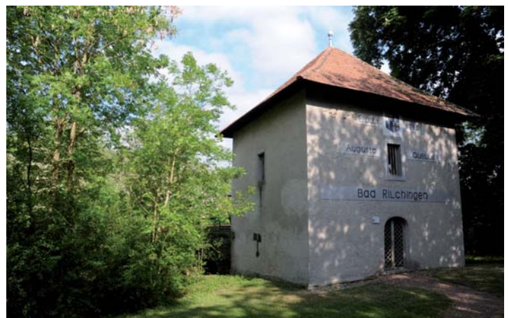
Augusta Quellturm in Bad Rilchingen-Hanweiler
