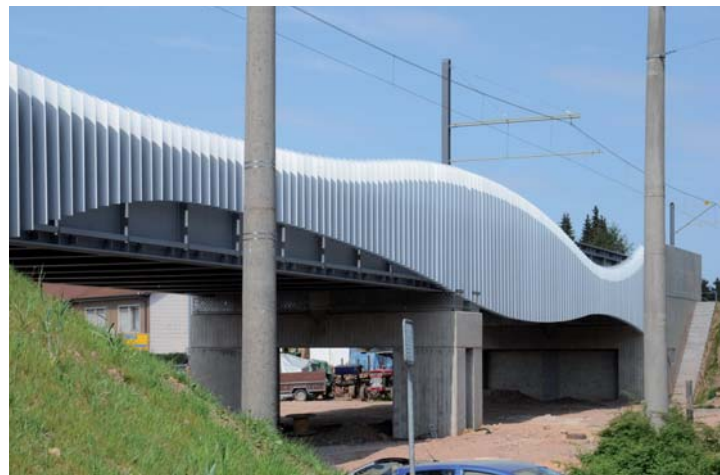
Die neue Saarbahnbrücke in Walpershofen
