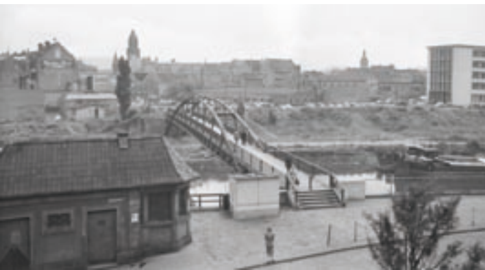
Als die Verbindung über die Saar noch Kummersteg hieß, waren auch die spätere Wilhelm-Heinrich-Brücke und die unter ihr verlaufende Stadtautobahn nur ein Traum.
