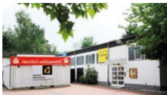
Nur wer sich ändert, bleibt sich treu: 2009 wurde das ehemalige Werkstattgebäude saniert und das Foyer um einen Neubau erweitert.
