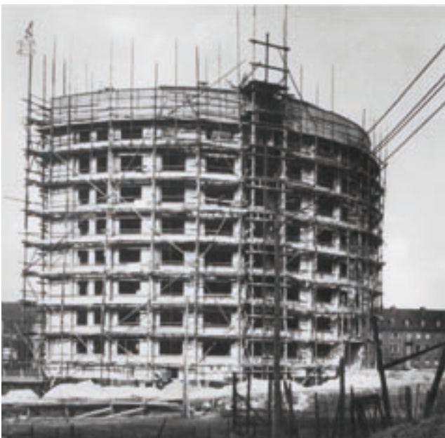
Neues Bauen als Symbol einer neuen Zeit: Die Architektur der Moderne hielt 1949/50 mit dem achtgeschossigen für Beamte der Saarregierung errichteten Wohnhaus im Stockenbruch in St. Arnual Einzug.
